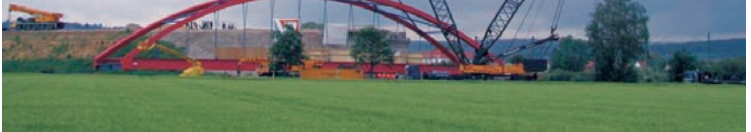
Der AK 850/1100 während des Probebehubs, im Vordergrund das „Traumschiff“, der LTF 1070.
