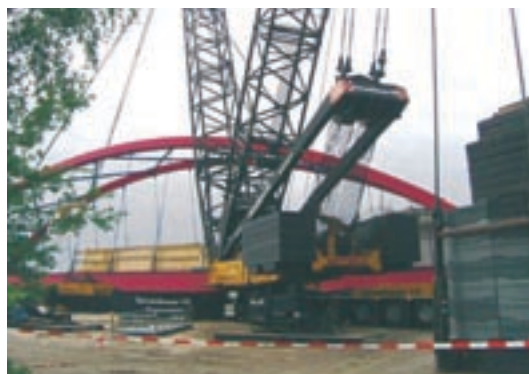
Der AK 850/110 mit 400 to Ballast auf der Maxibühne und die Brücke in schwebendem Zustand.
